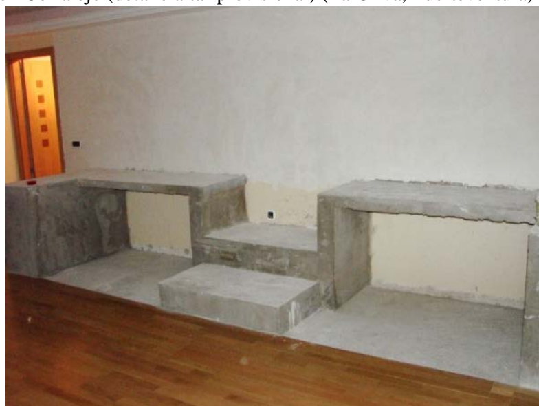
(Durga Mata Mandir en Corralejo (altar en construcción) (La Oliva, Fuerteventura) (foto: Néstor Verona)
