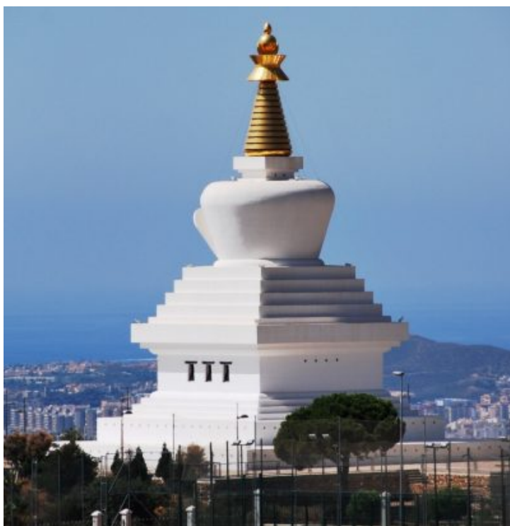
Vista general del estupa de Benalmádena (Málaga). Foto cortesía del autor
